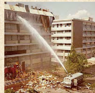
屋上からの火炎ピン攻撃に、機動隊は大阪府警から導入した放水車で対抗した。
