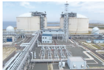
ひびきLNG基地内LNGタンク ひびきエル・エヌ・ジー株式会社提供
