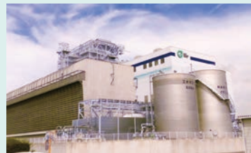
海田バイオマスパワー株式会社 海田発電所
